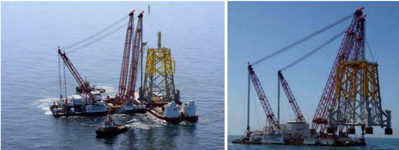
Figuur 6: Impressie van het plaatsen van het jacket.
