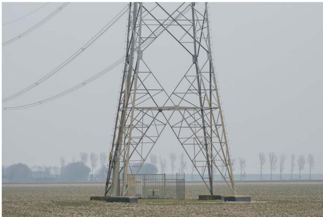
Figuur 18 Bestaand beeld tweepaalspoer (mast 171)
