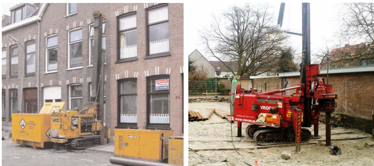
Figuur 19 Voorbeeld van heistelling voor inwendig geheide buispaal (links) en schroefinjectiepaal (rechts)
