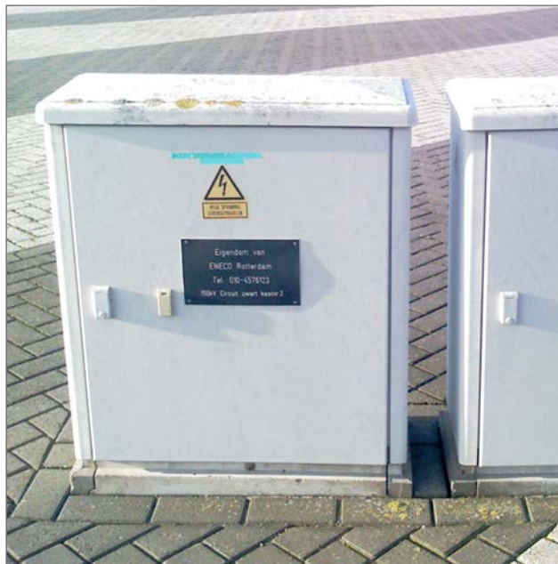
fig. 7 Voorbeeld van een cross-bondingkast
