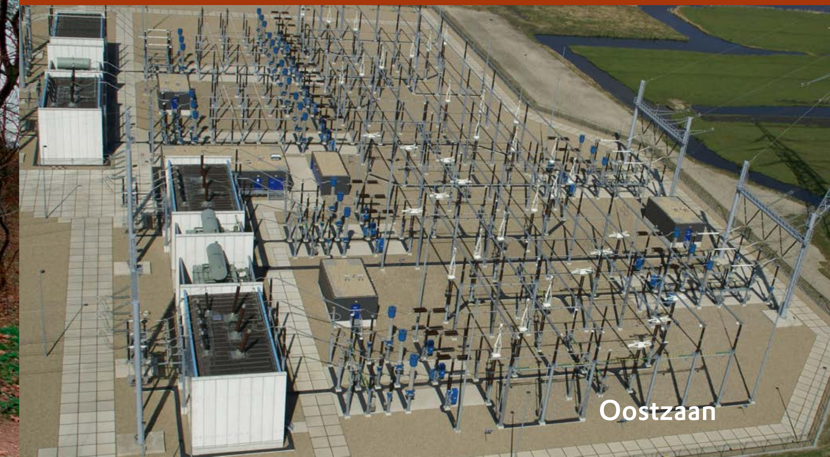
Fotoimpressie: zicht op het transformatorstation vanaf het fietspad langs de Zeestraat.
