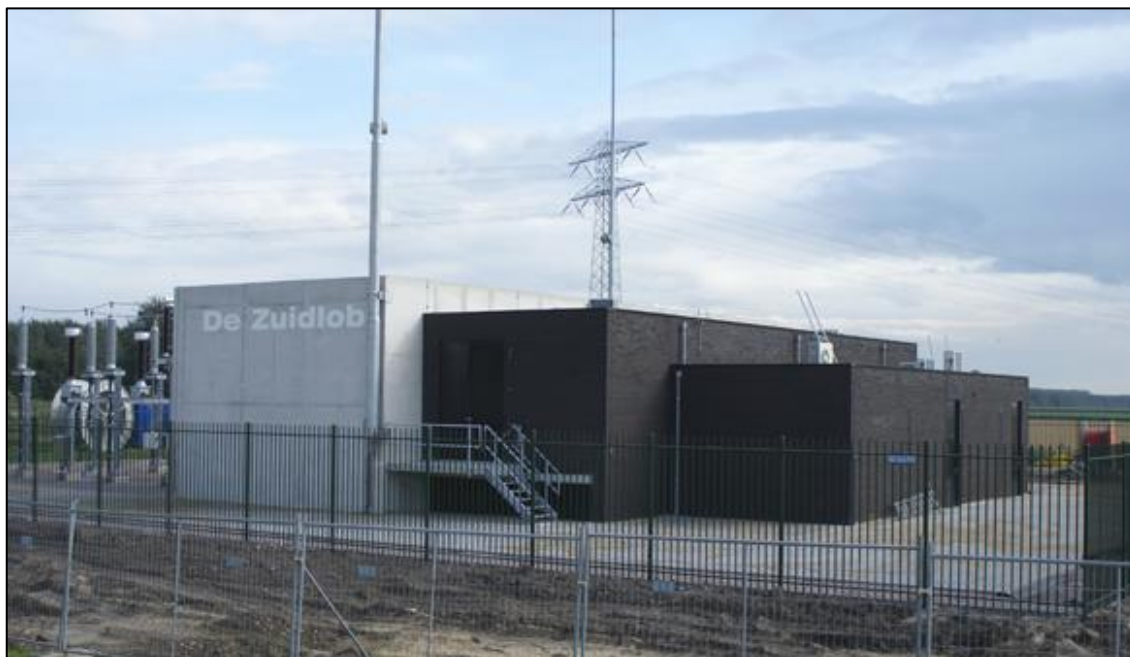
Figuur 2.3: Onderstation Zuidlob (zijkant)
