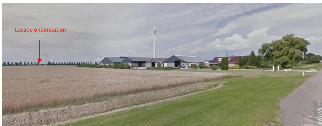
Figuur 2.2: Zicht vanaf de openbare weg (Rivierduinweg)
