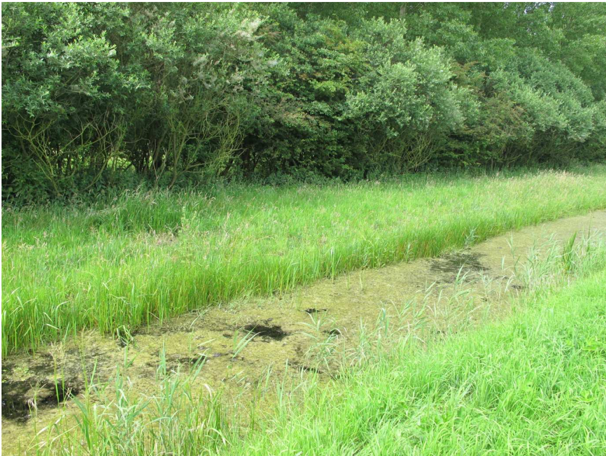
14) Onderzijde talud westzijde A9 richting uitredepunt
