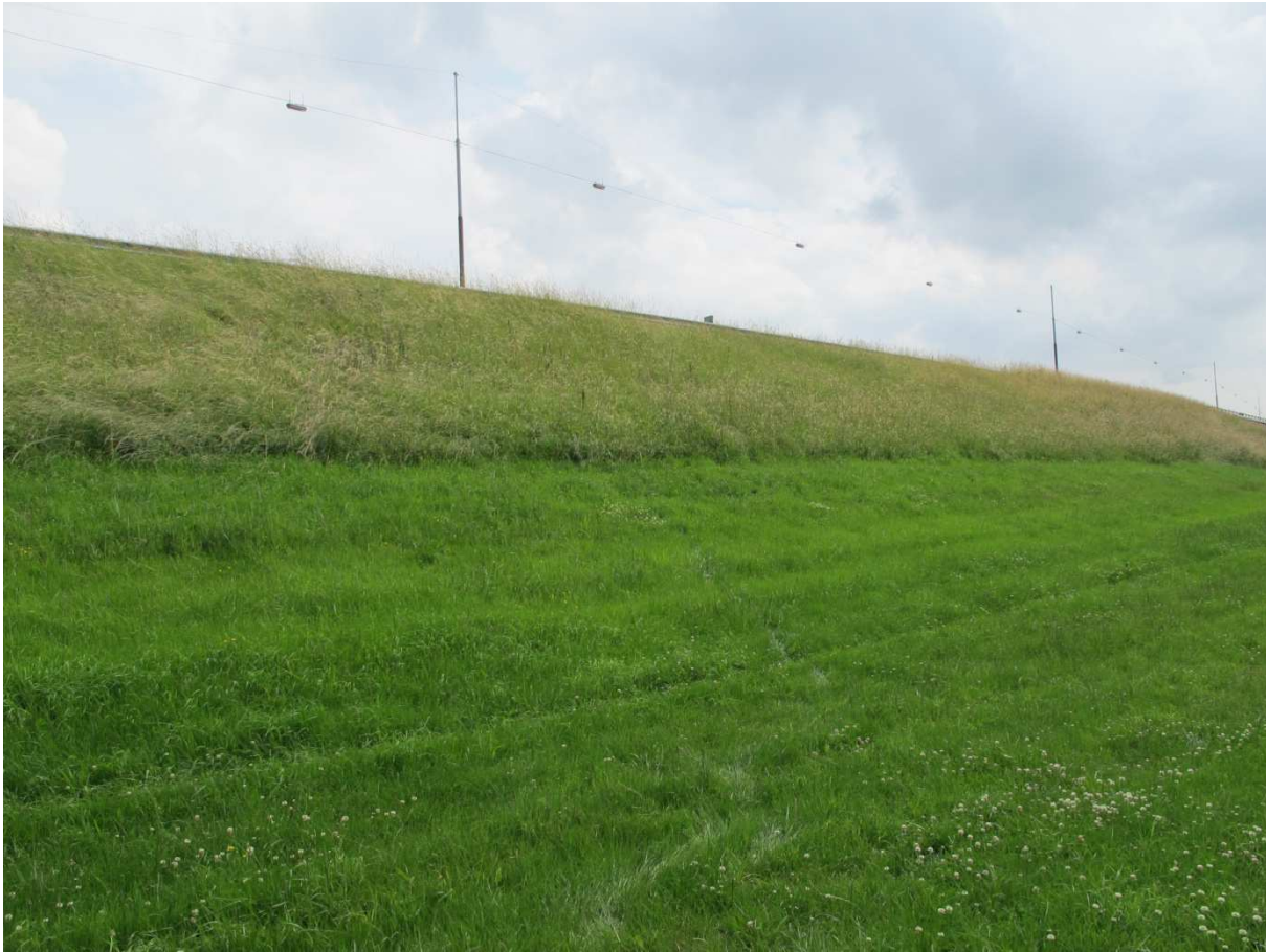
13) Onderzijde talud westzijde A9 richting intredepunt
