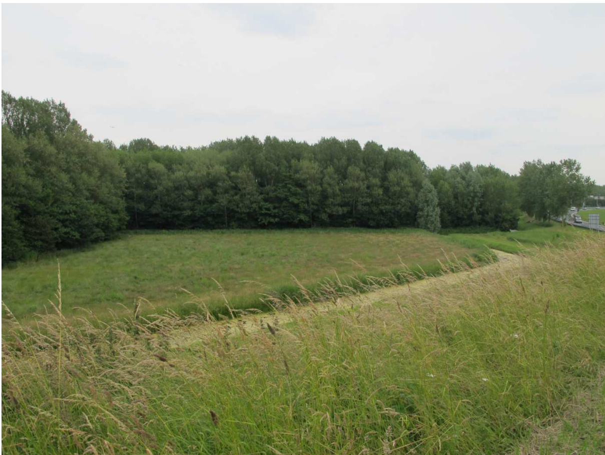
8) Vanaf oostzijde A9 bovenzijde richting intredepunt
