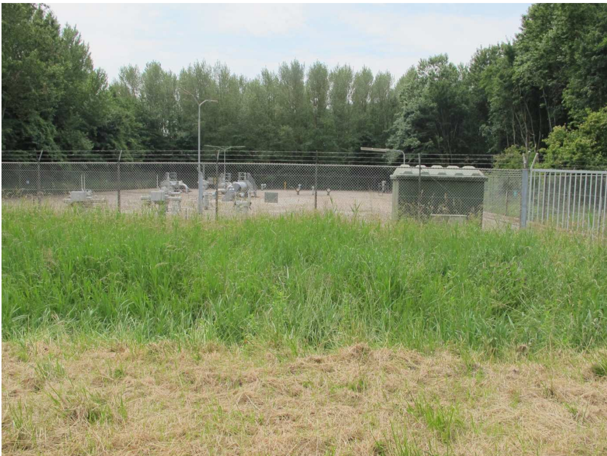
18) Gasuniestation wat aan de achterzijde gekruist wordt
