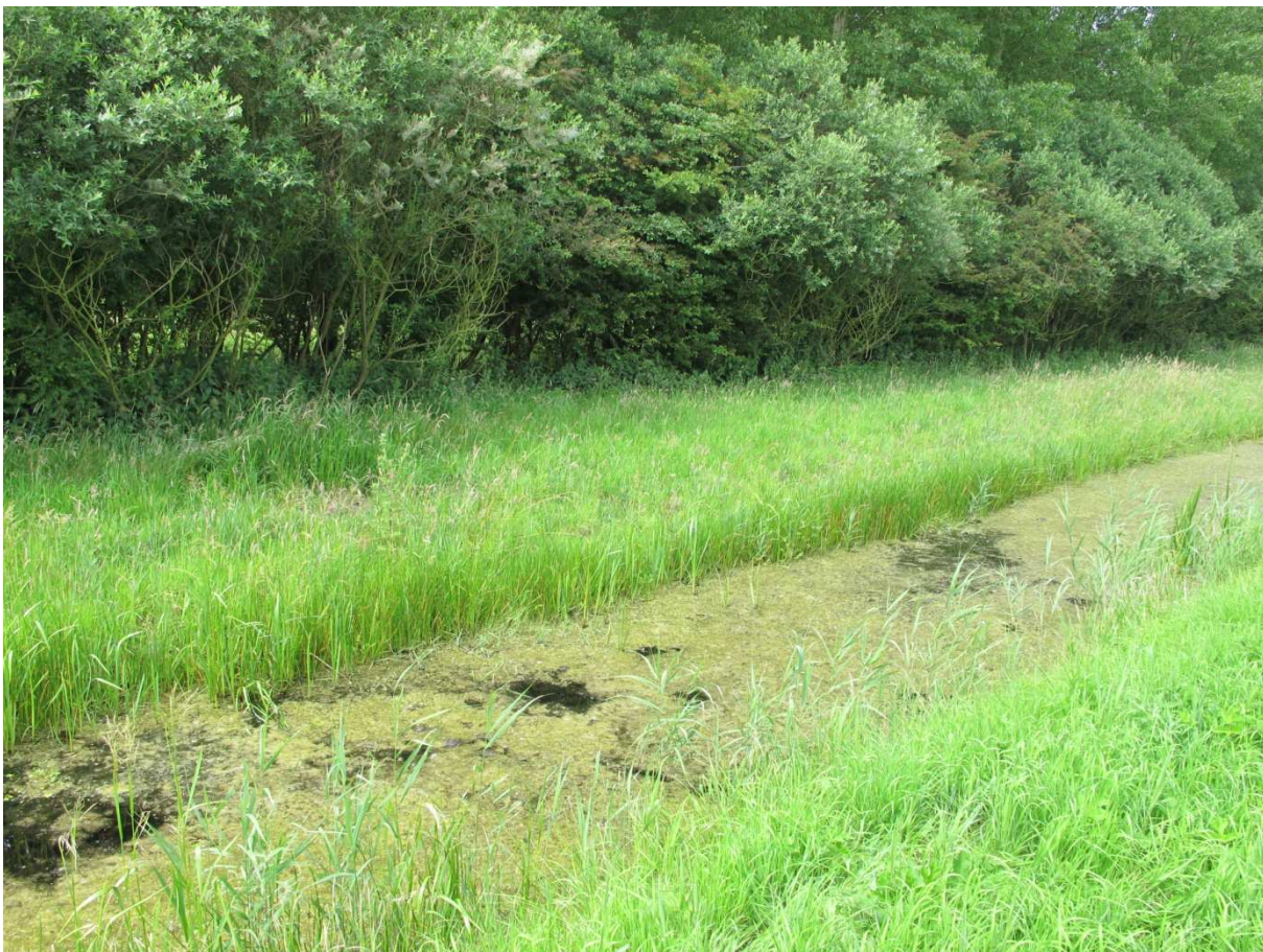
14) Onderzijde talud westzijde A9 richting uitredepunt
