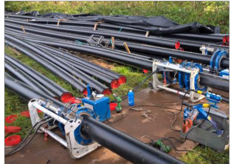
fig. 6 Mantelbuizen op uitleglocaties
