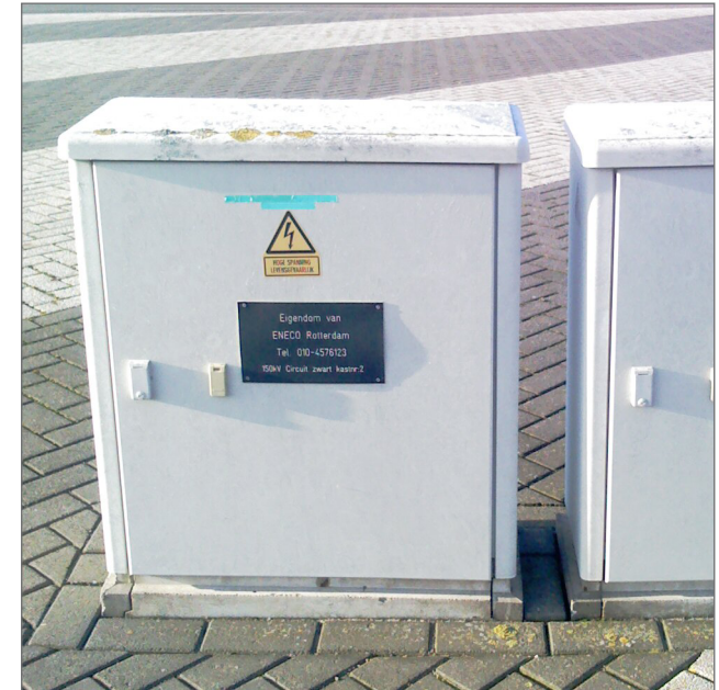
fig. 4 Voorbeeld van een cross-bondingkast
