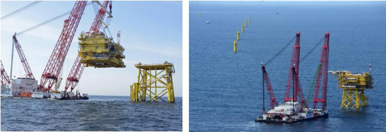
Figuur 3.3: Impressie van het plaatsen van de topside.
