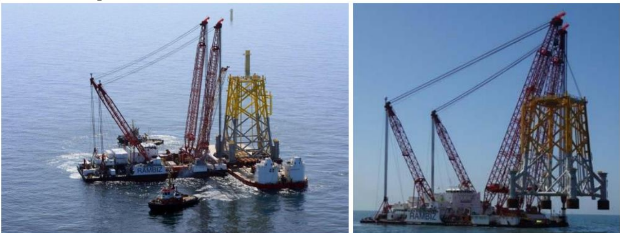
Figuur 3.2: Impressie van het plaatsen van het jacket.
