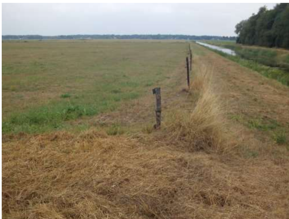
Figuur 1: Het langs het Dwarsdiep gelegen deel van het tracé, gezien vanuit het zuiden.
