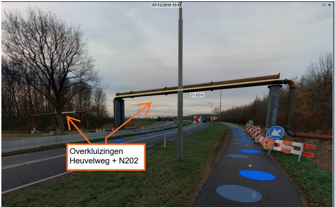
Figuur 7: Weergave route watertransportleiding (Overkluizing Heuvelweg en N202 Amsterdamseweg) (bron: Globespotter by Cyclomedia, bewerkt)
