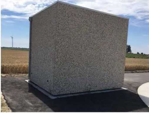
Figuur 3.1 Voorbeeld foto Inkoopstation
