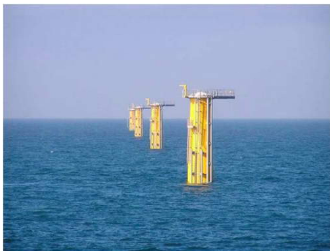
Figuur 6-6 Foto van een funderingspaal van een turbine in het Prinses Amalia park (foto van website: http://www.prinsesamaliawindpark.eu/ )
