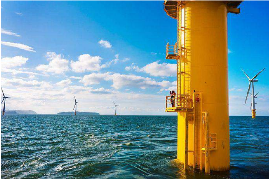
Afbeelding 6.17 Voorbeeld van een monopile
