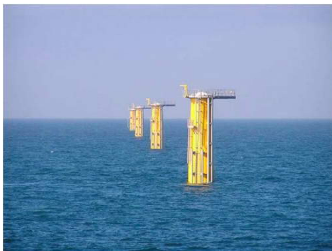
Figuur 6-6 Foto van een funderingspaal van een turbine in het Prinses Amalia park (foto van website: http://www.prinsesamaliawindpark.eu/ )
