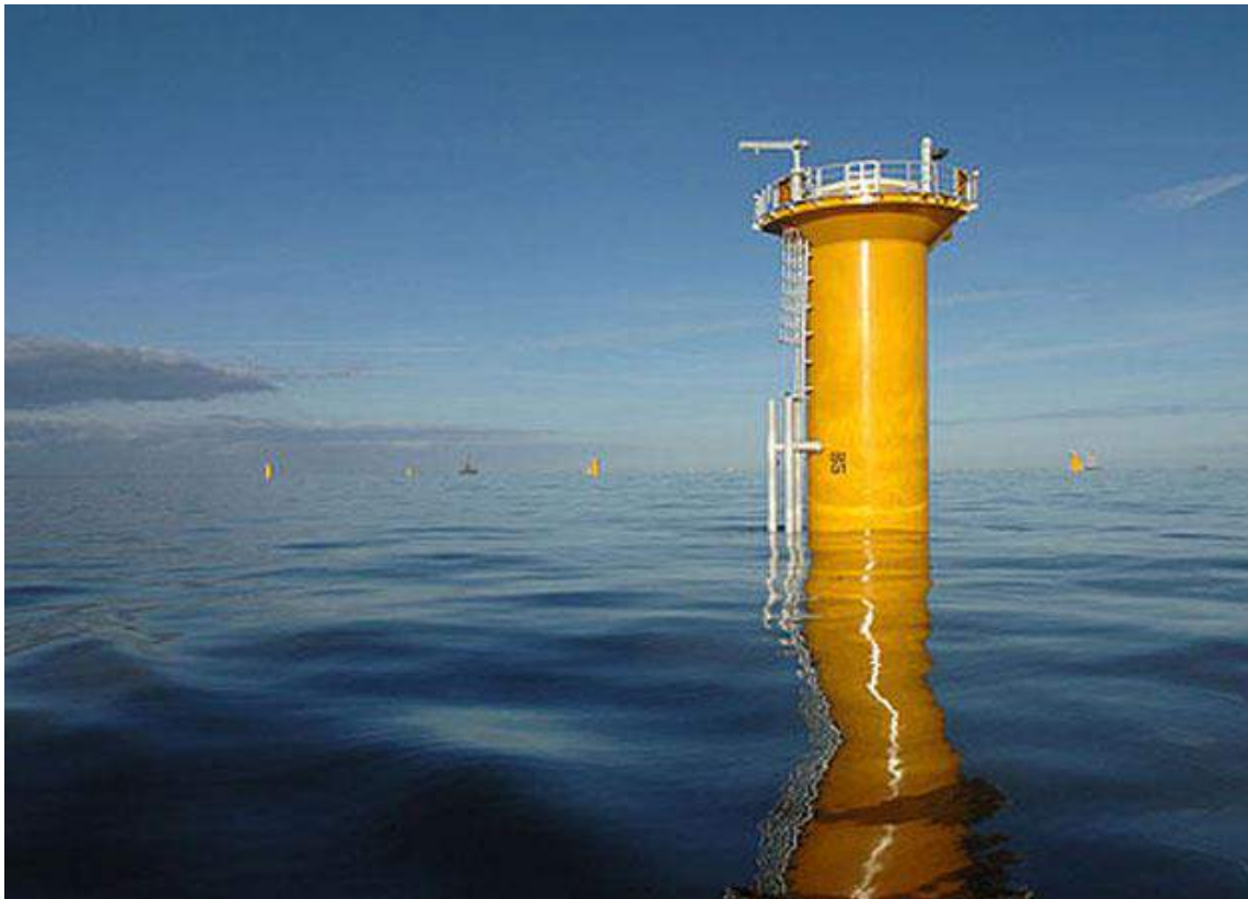
Afbeelding 4.4 Voorbeeld van een monopile-fundatie
