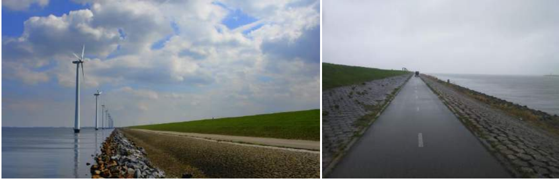
Afbeelding 6.5 Links naar rechts: Bekleding IJsselmeerdijken, bekleding Ketelmeerdijk
