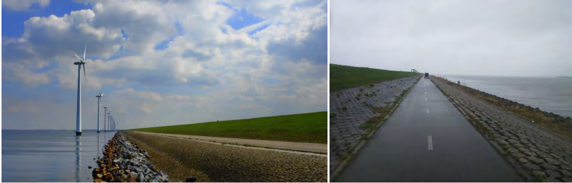
Afbeelding 6.5 Links naar rechts: Bekleding IJsselmeerdijken, bekleding Ketelmeerdijk
