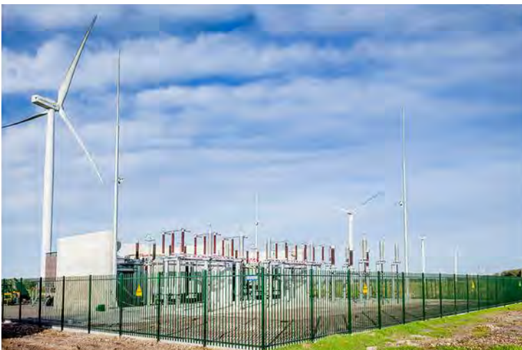
Afbeelding 2.9 Onderstation bij Prinses Alexia Windpark. Bron: Nuon
