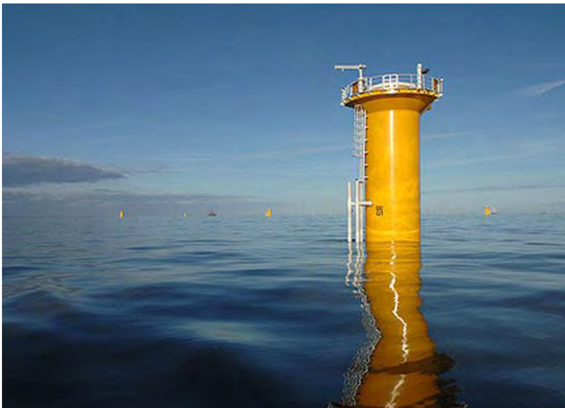
Afbeelding 4.4 Voorbeeld van een monopile-fundatie
