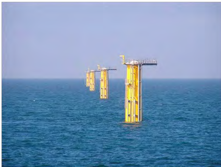
Figuur 6-5 Foto van een funderingspaal van een turbine in het Prinses Amalia park (foto van website: http://www.prinsesamaliawindpark.eu/ )
