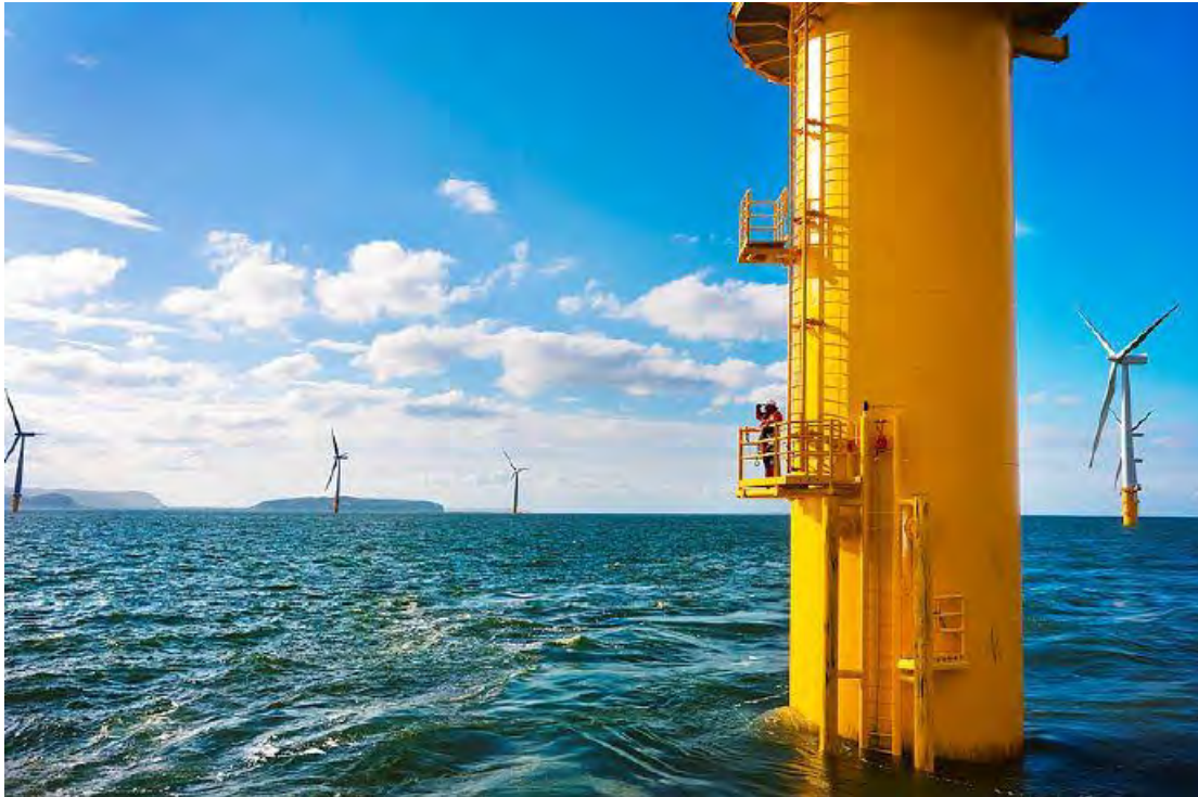
Afbeelding 6.17 Voorbeeld van een monopile
