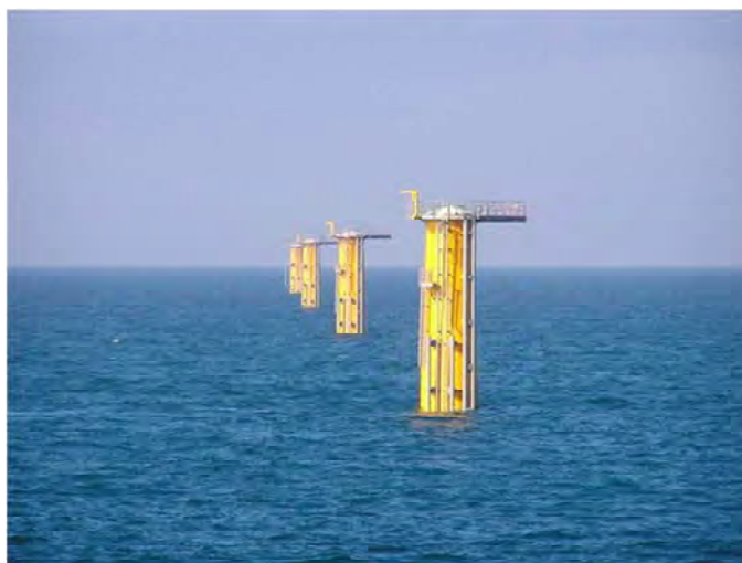
Figuur 6-6 Foto van een funderingspaal van een turbine in het Prinses Amalia park (foto van website: http://www.prinsesamaliawindpark.eu/ )
