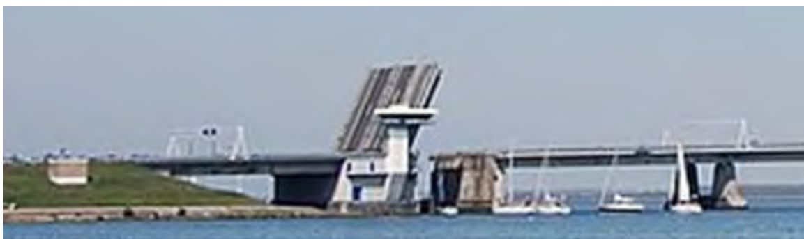
Afbeelding 6.27 Ketelbrug met wachtende zeilschepen, gezien vanaf het Ketelmeer
