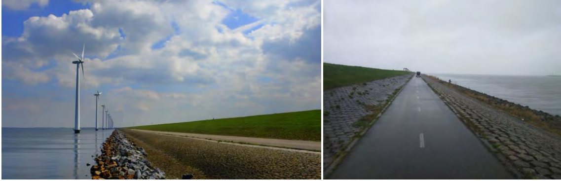
Afbeelding 6.5 Links naar rechts: Bekleding IJsselmeerdijken, bekleding Ketelmeerdijk
