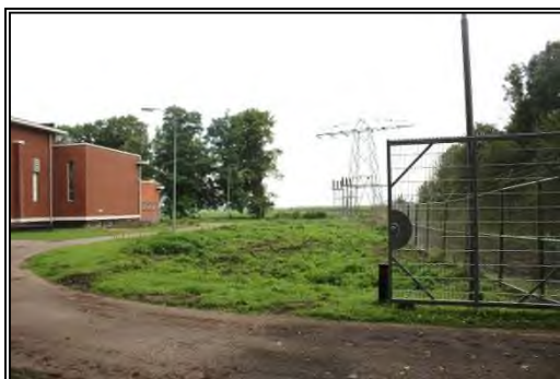
Figuur 4.1. Locatie trafoputten.
