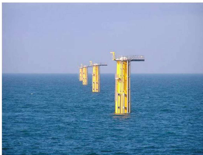
Figuur 6-6 Foto van een funderingspaal van een turbine in het Prinses Amalia park (foto van website: http://www.prinsesamaliawindpark.eu/ )
