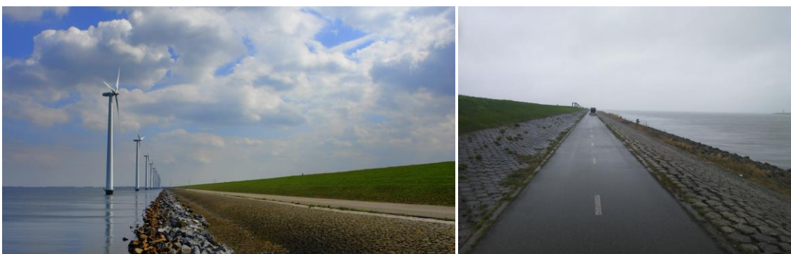
Afbeelding 6.5 Links naar rechts: Bekleding IJsselmeerdijken, bekleding Ketelmeerdijk
