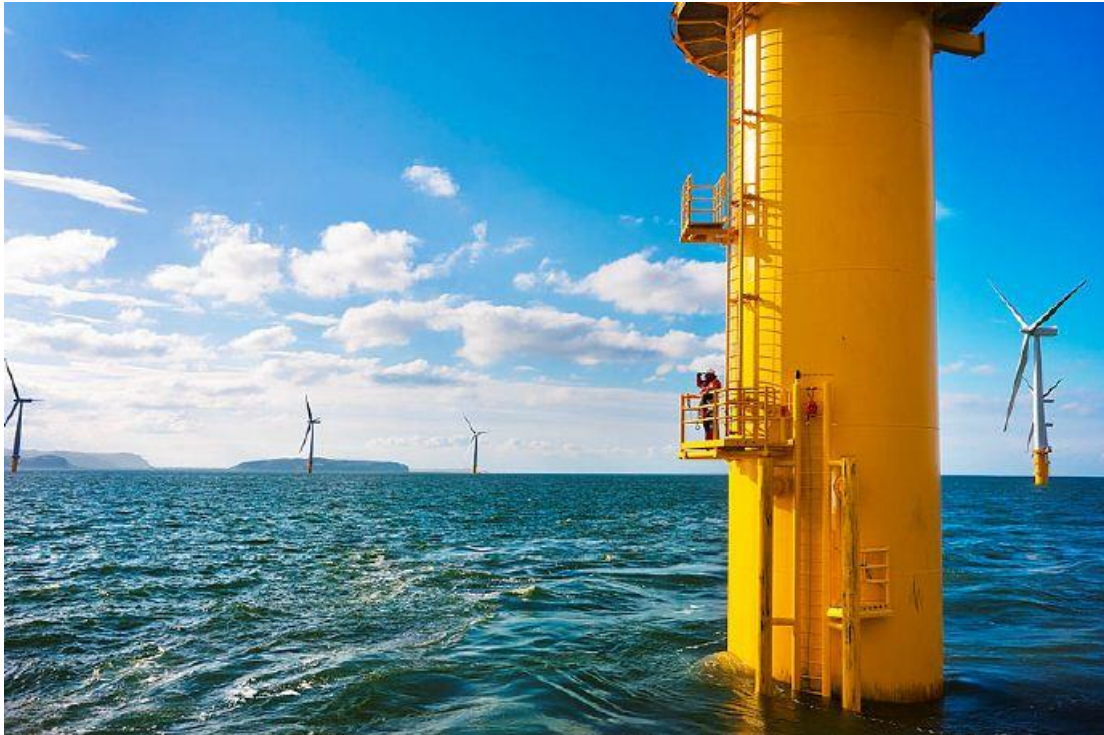
Afbeelding 6.19 Voorbeeld van een monopile
