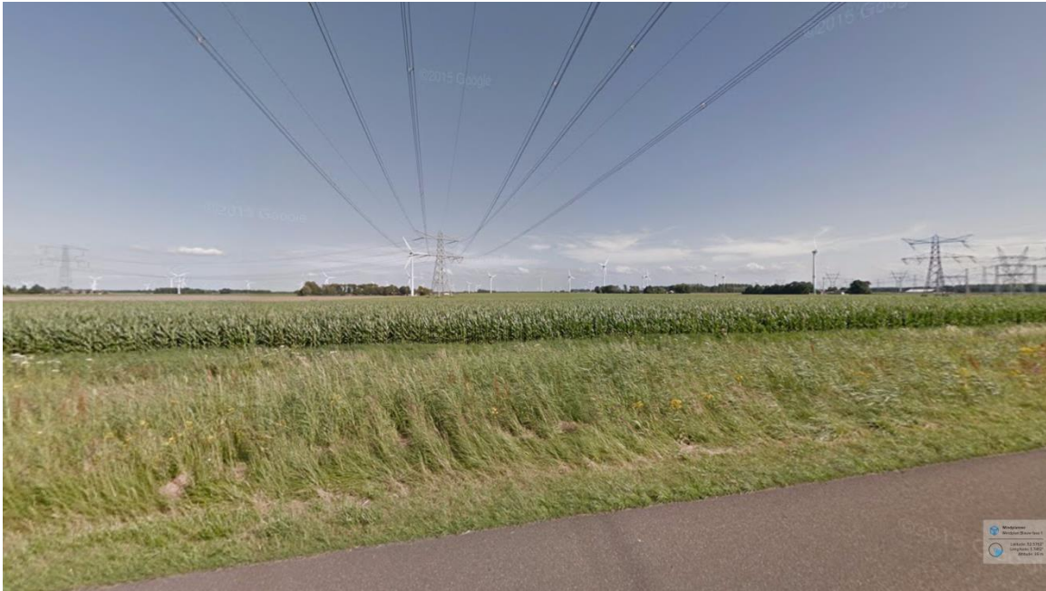
Afbeelding 3.5 Foto vanaf de A6 met rommelig beeld hoogspanningsmasten en huidige windturbines
