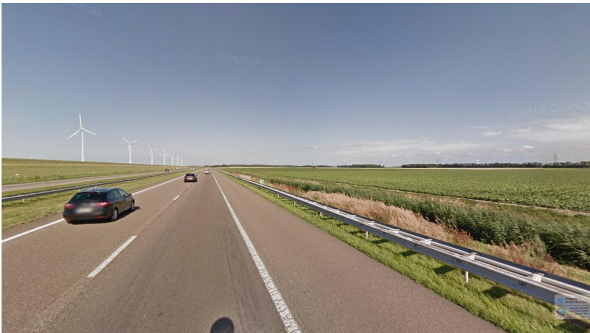
Afbeelding 3.6 Foto vanaf de A6 met lijnopstelling buitendijks
