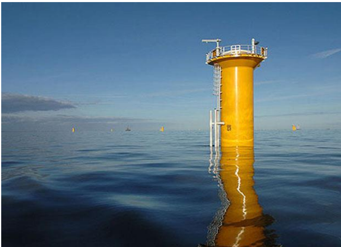
Afbeelding 4.4 Voorbeeld van een monopile-fundatie
