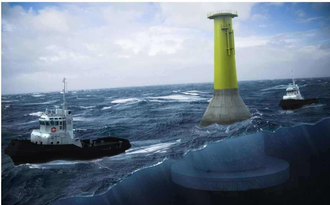
Afbeelding 4.7 Illustratie van een Gravity Based Foundation
