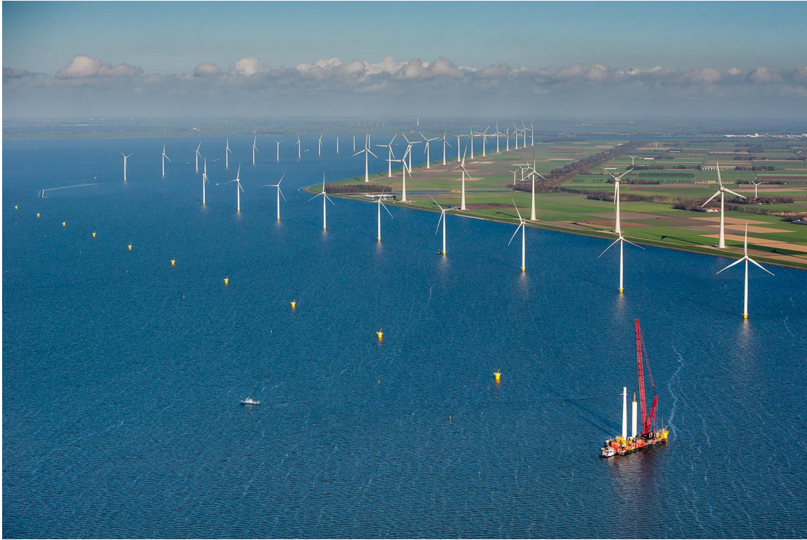
Afbeelding 2.3 Windpark Noordoostpolder tijdens de bouw. De windturbines in het water hebben hier een ashoogte van 95 m met een tiphoogte van 148,5 m. De landturbines hebben een ashoogte van 135 m en een tiphoogte van 198,5 m
