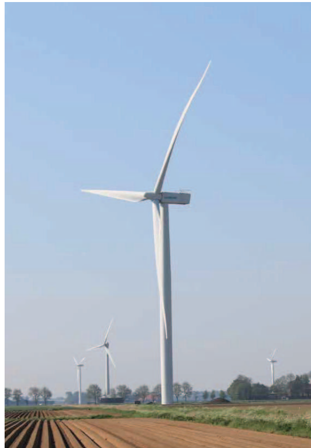
fig. 6) Siemens SWT 3.6 Tiplaagte 20 meter. De turbine gezien vanaf 780 meter. Wegbeplanting (ca 10m hoog) staat op ongeveer 800 meter hierachter.
