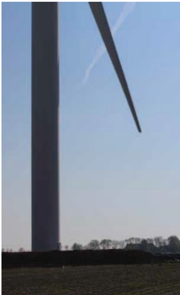
fig 8) Siemens SWT 3.6; Tiplaagte 20 meter
