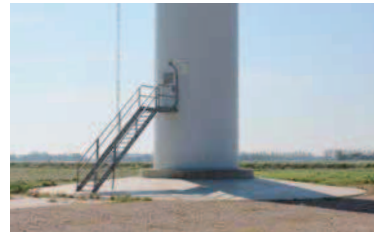
Voorbeeld oplopende betonnen mastvoet in de Wieringermeer
