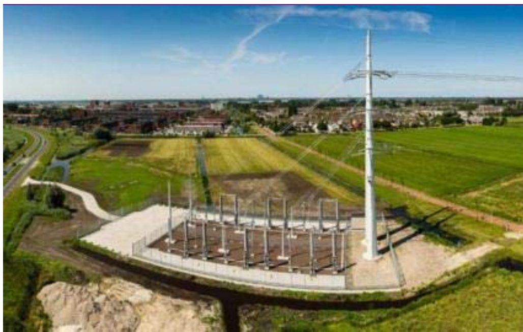
Figuur 3.10 Opstijgpunt Pijnacker langs de N470 (richting hoogspanningsstation Bleiswijk)
