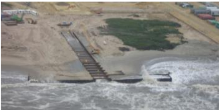
Figure 22 Landfall using a cofferdam [courtesy: Voorbij B.V.]
