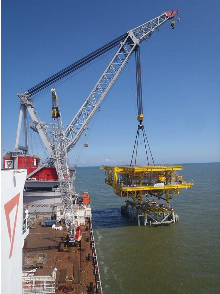
Afbeelding XI.3 Installatie van de topside
