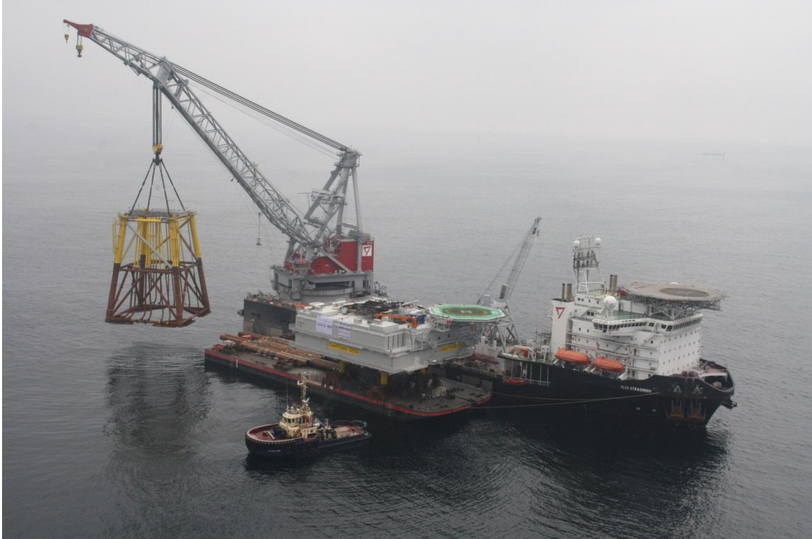
Afbeelding XI.2 Installatie Jacket
