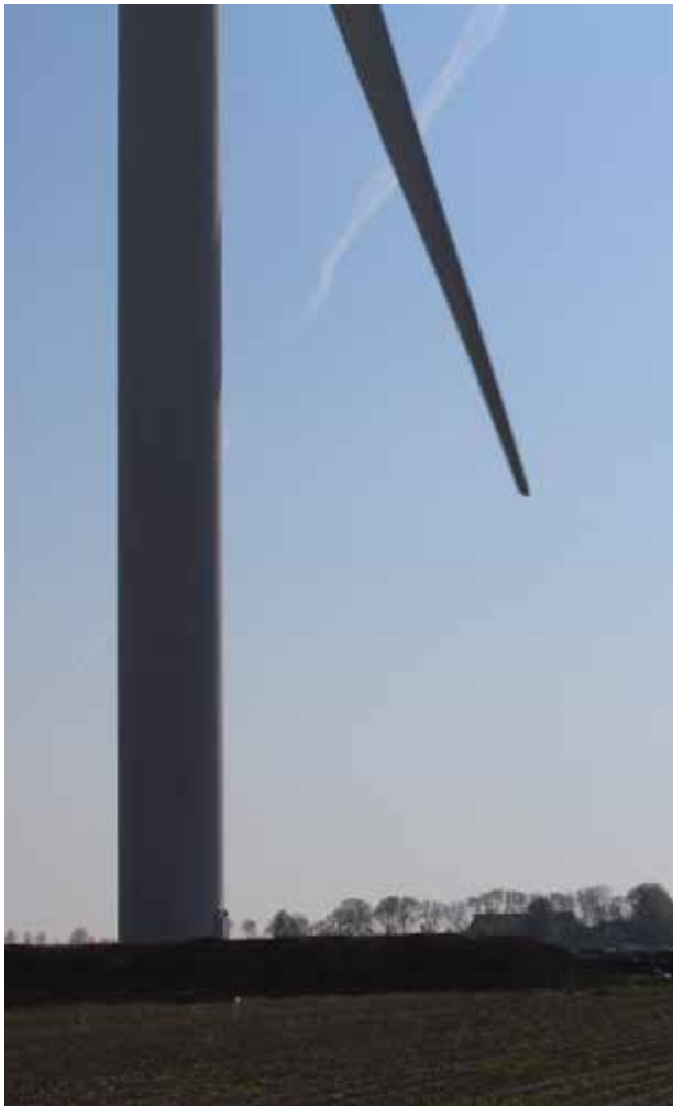
fig 8) Siemens SWT 3.6; Tiplaagte 20 meter
