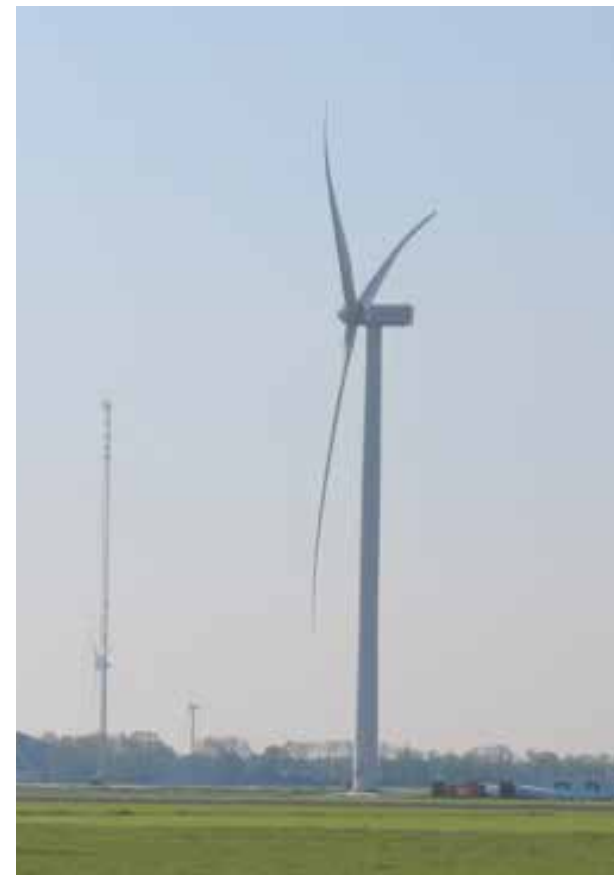
fig 7) GE 2.75-120. Tiplaagte 25 meter
