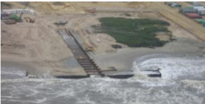
Figure 22 Landfall using a cofferdam [courtesy: Voorbij B.V.]
