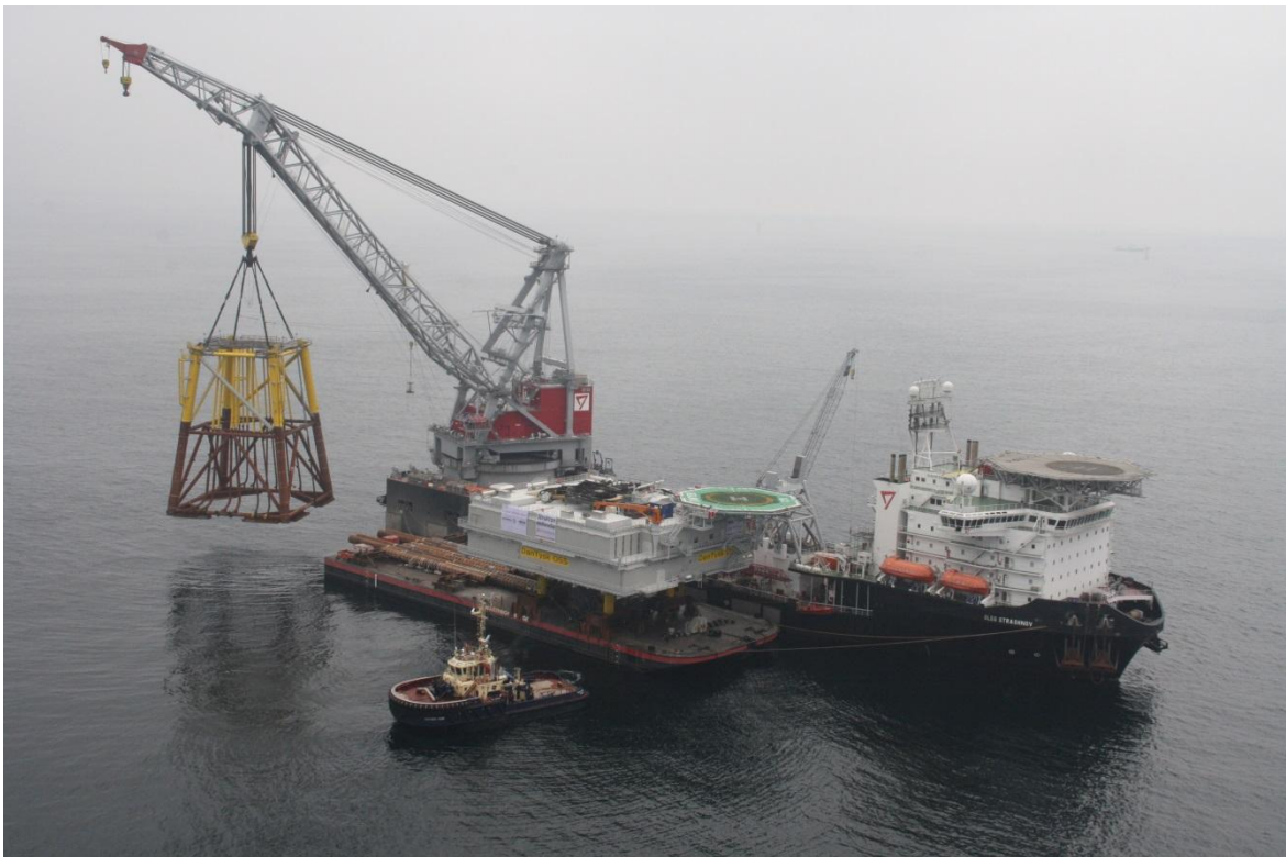
Afbeelding 3.1 Installatie Jacket
