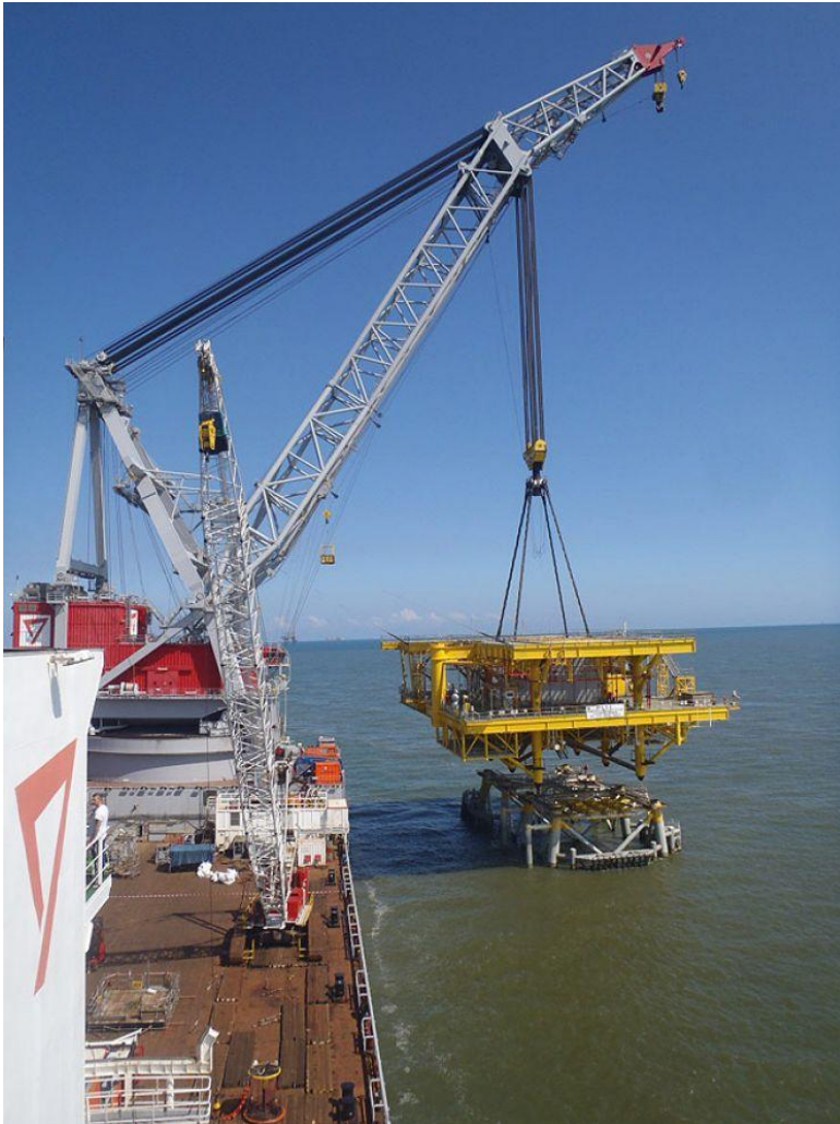
Afbeelding 3.2 Installatie van de topside
