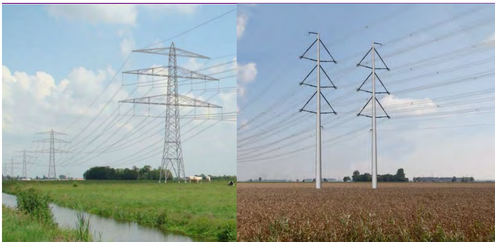
Figuur 2.3 Vakwerkmast (links) en wintrackmast (rechts)
