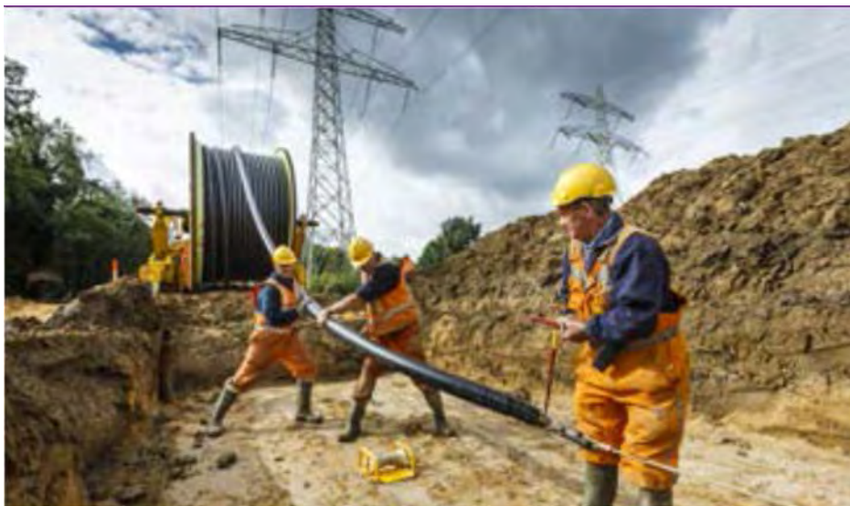
Figuur 2.7 Open ontgraving, sleuven graven en kabels trekken
