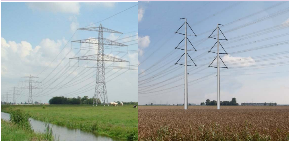
Figuur 3.2 Vakwerkmast (links) en wintrackmast (rechts)
