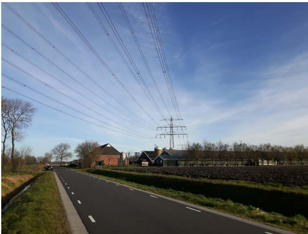
Figuur 4.4 Bestaande 220 kV verbinding ten noorden van Stedum bij de Weer (kijkrichting oost)
