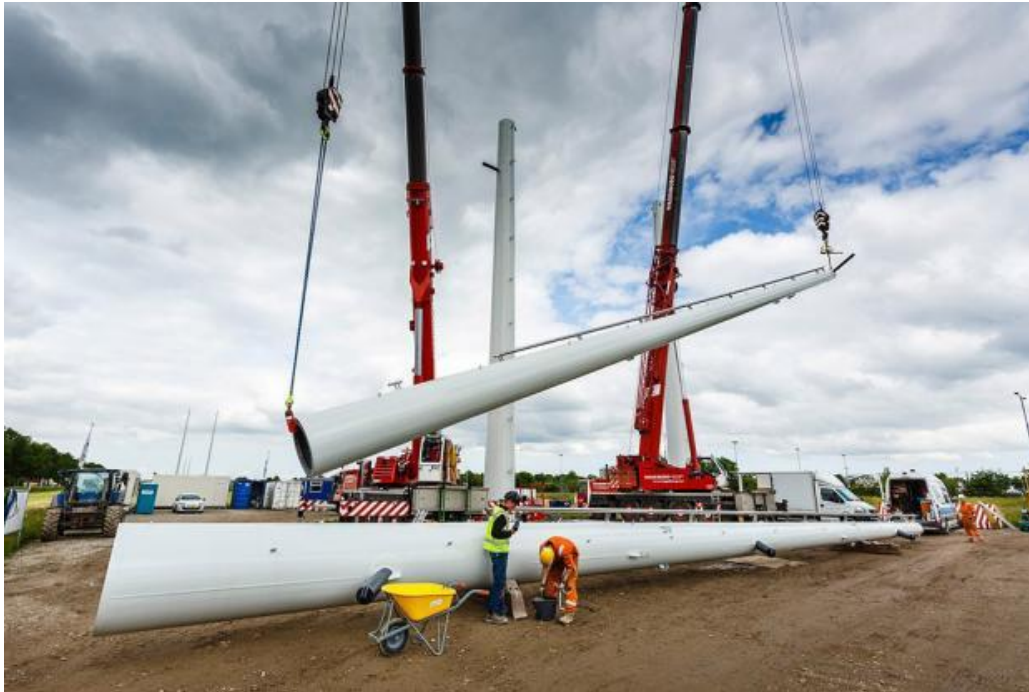
Foto 6: plaatsing van een Wintrackmast
