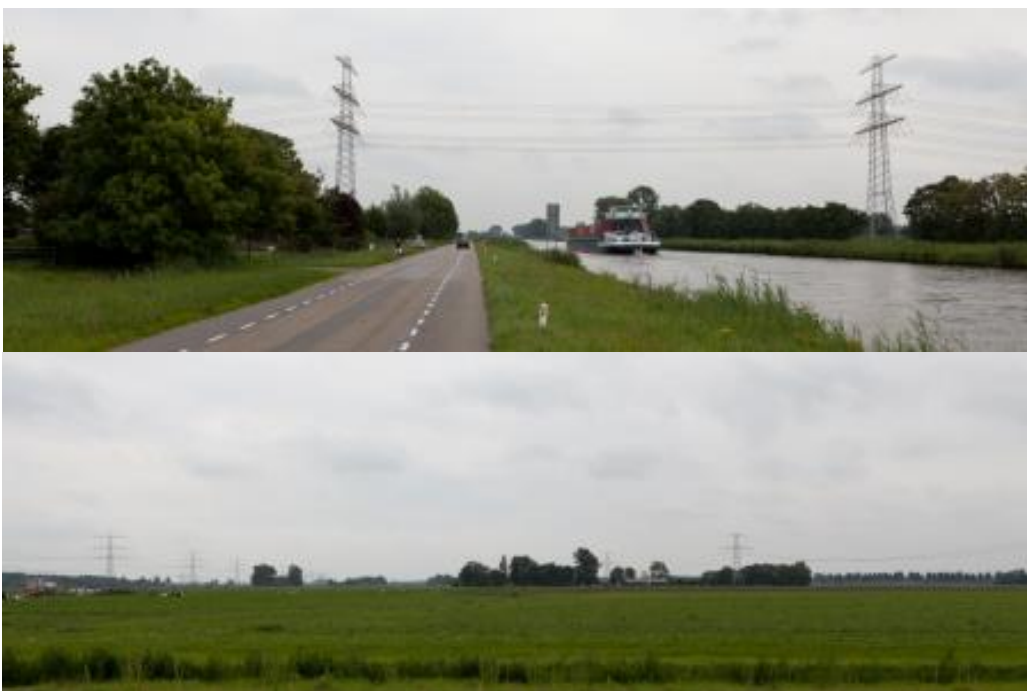
Foto 12: Aduarderdiep met bestaande 110 en 220 kV-verbindingen
