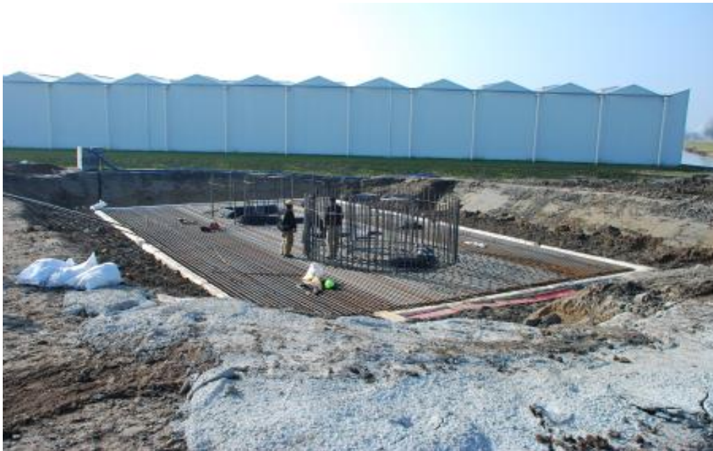
Foto 16: Aanbrengen bewapening
