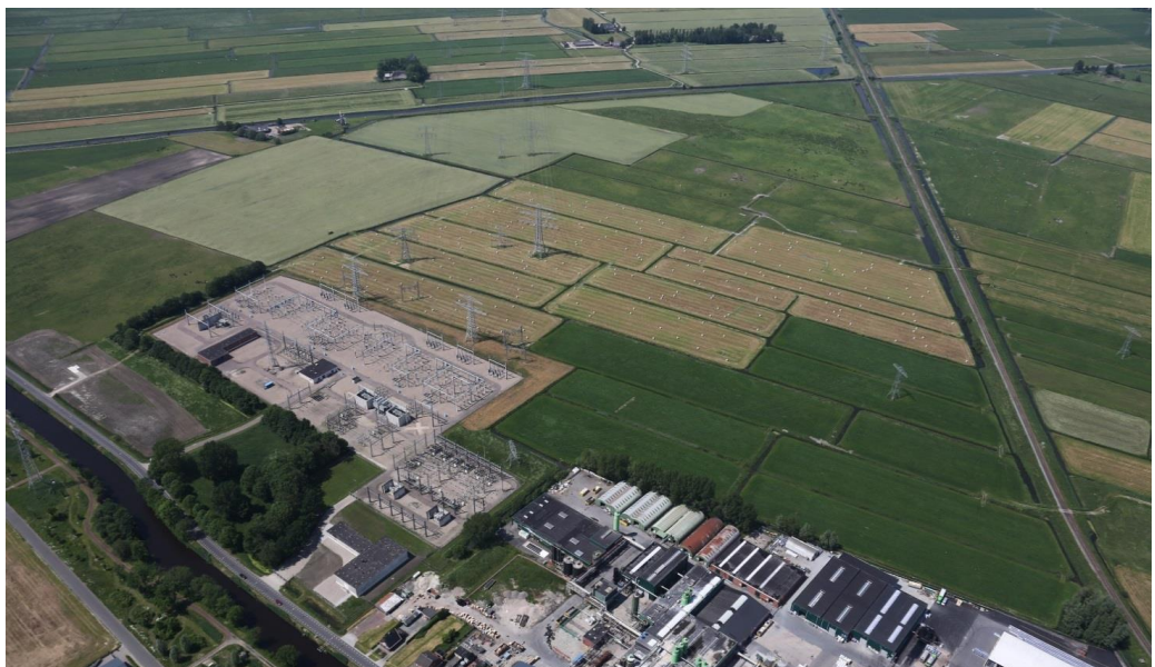
Foto 4: Bedrijventerrein Westpoort met transformatorstation Vierverlaten
