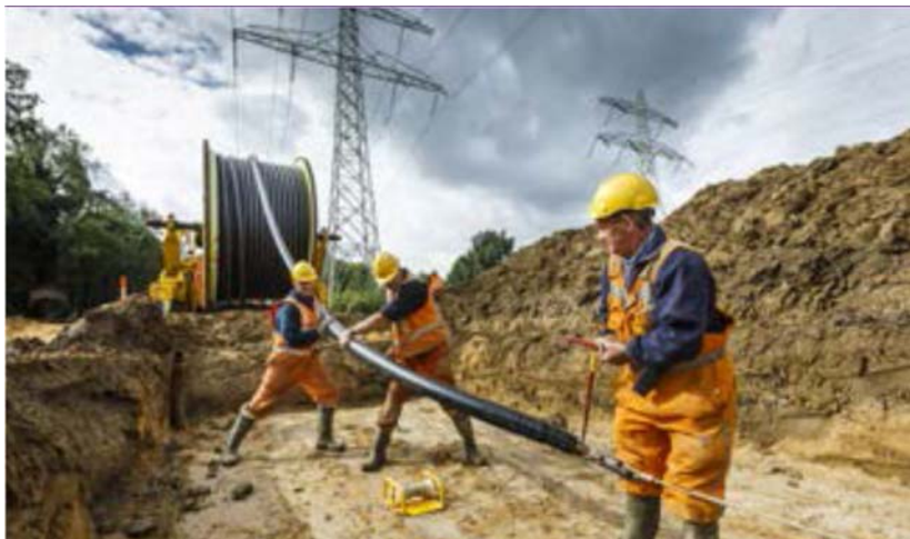
Figuur 3.7 Open ontgraving, sleuven graven en kabels trekken
