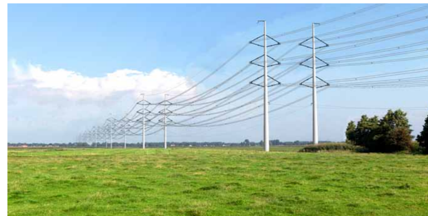
De vier circuit Wintrack mast
