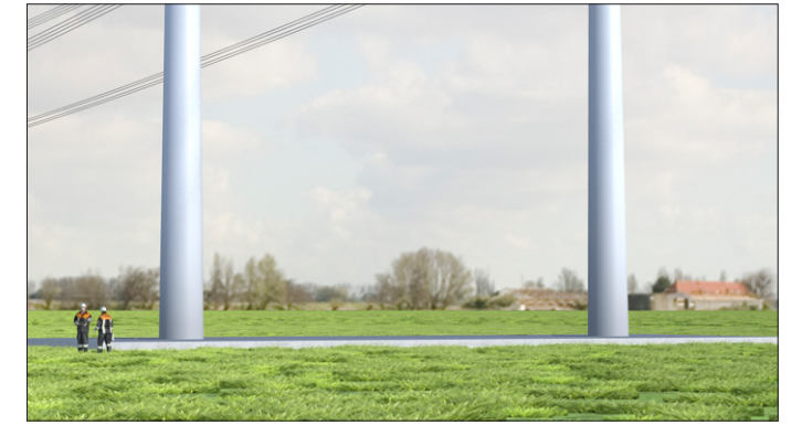
Fundatie over geheel 0.3m boven maaiveld.
