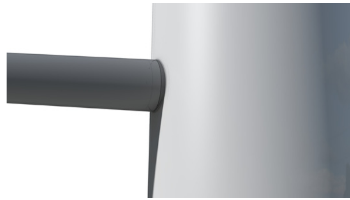
geen zichtbare verbinding, brace is aangelast
