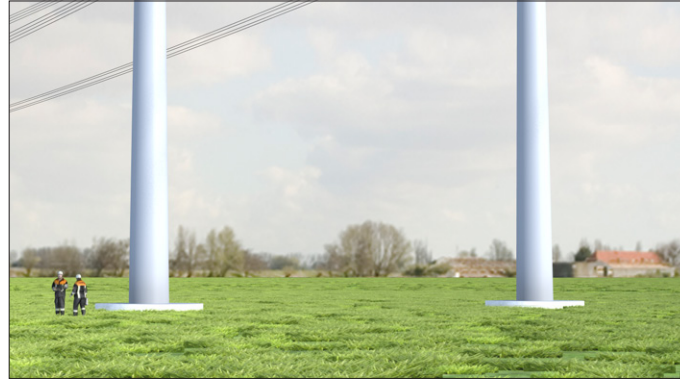
Fundatie met ronde opstort van 0,3m boven maaiveld. Hoogte gras (extensief beheerd en ongemaaid) 0,1m
