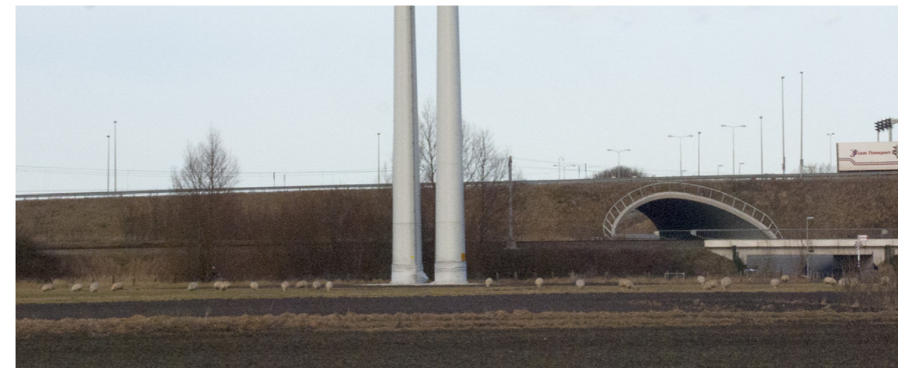
Aangepaste fundatie bij Bleiswijk, de volledige fundatie gelijk aan maaiveld
