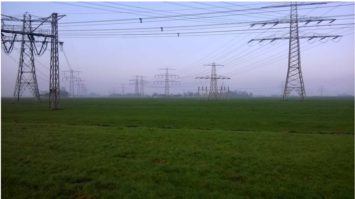
Tracé hoogspanningsleidingen (foto's zijn genomen vanaf de noordzijde van het huidige HS-station)
