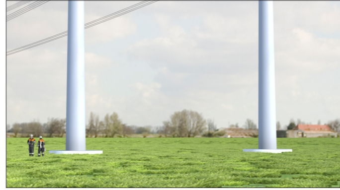
Fundatie met ronde opstort van 0,3m boven maaiveld. Hoogte gras (extensief beheerd en ongemaaid) 0,1m
