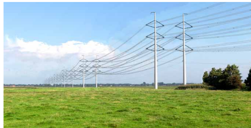
De vier circuit Wintrack mast
