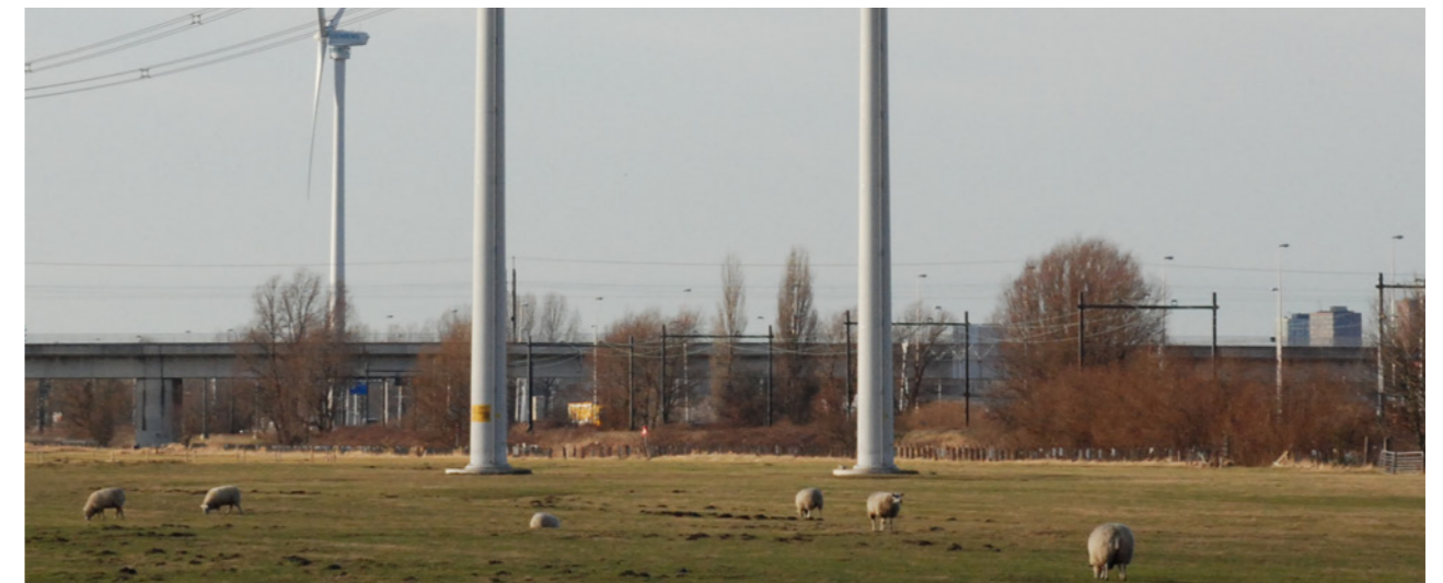
Fundatie bij Bleiswijk met de opstort van fundatie 0.3m boven maaiveld
