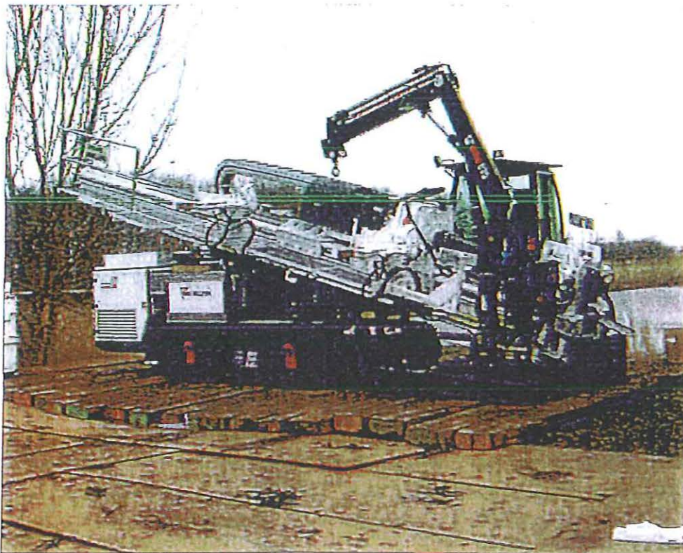
Afbeelding: 100 tons boor-rig Van Vulpen
