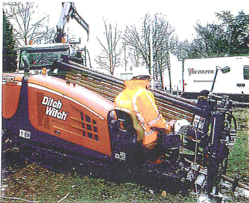
Afbeelding: 10 tons boor-rig Van Vulpen
