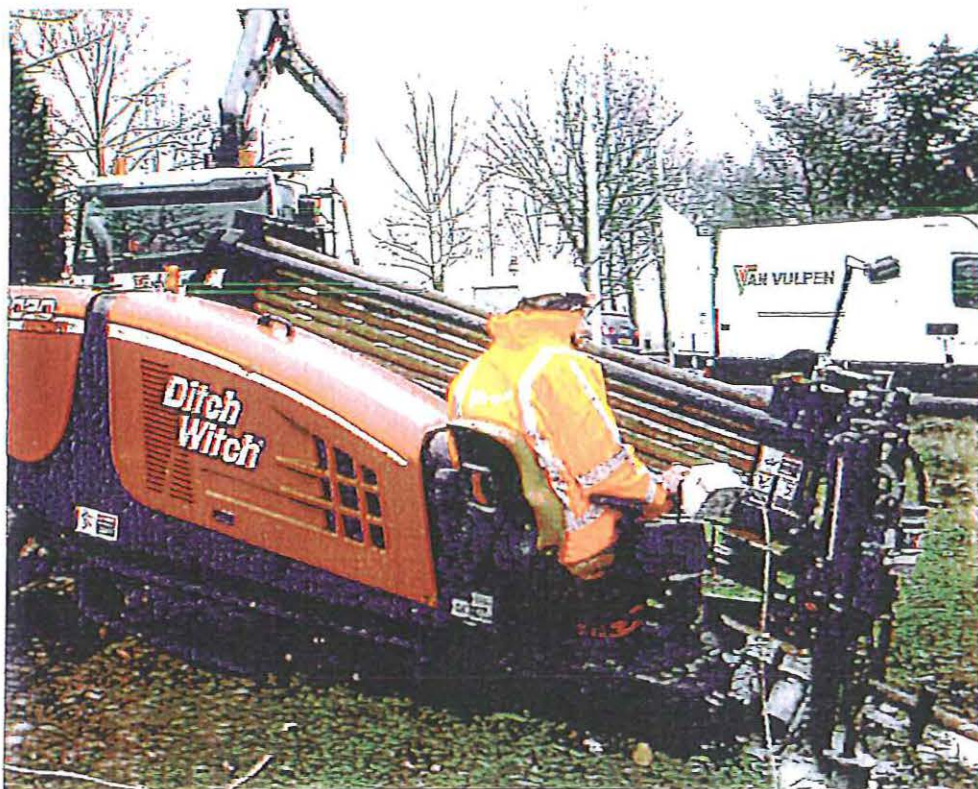
Afbeelding: 16 tons boor-rig Van Vulpen
