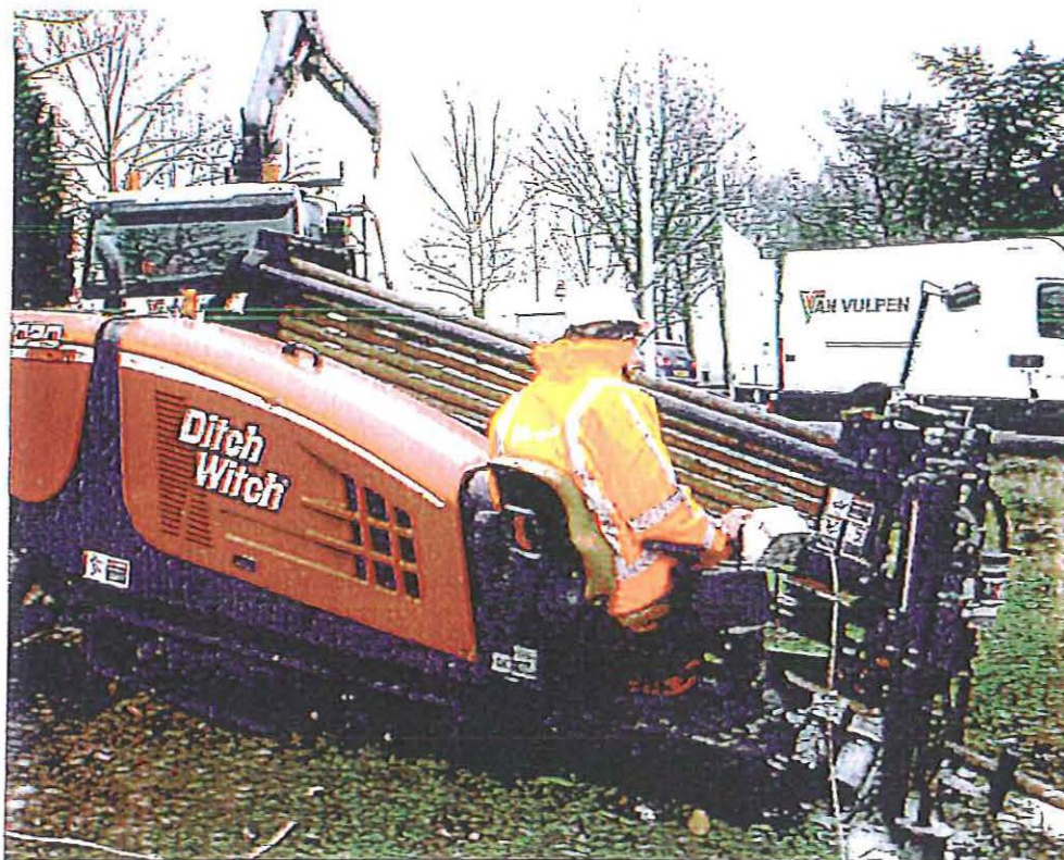
Afbeelding: 16 tons boor-rig Van Vulpen
