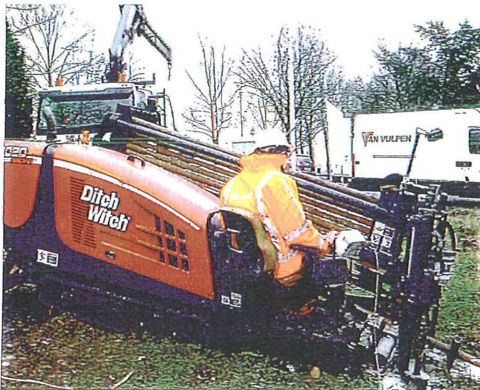
Afbeelding: 10 tons boor-rig Van Vulpen
