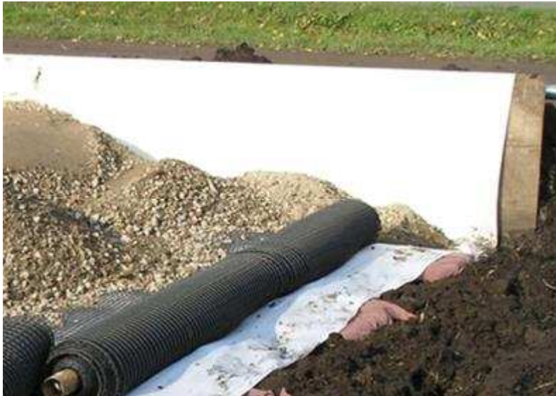
Figuur 7 Voorbeeld grid (grijs, langsrichting) op doek (wit, dwarsrichting)
