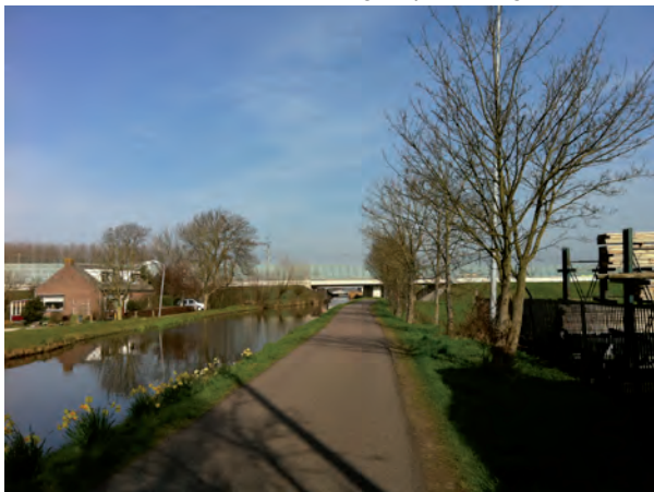
Stingsloot en viaduct HSL
