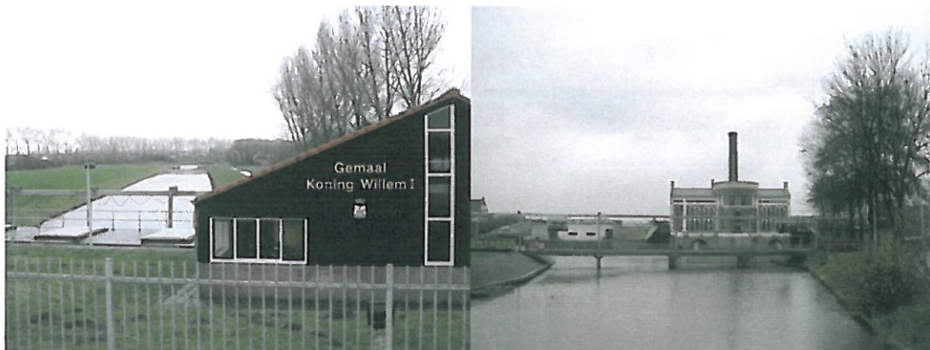
Figuur 4.3 Gemaal Koning Willem I (links), gemaal Lijnden (rechts)
