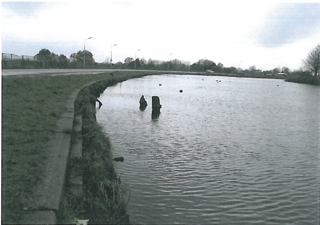
Figuur 4.4 Ringvaart langs de Haarlemmermeerpolder in de buurt van station Vijfhuizen met links de ringvaardijk
