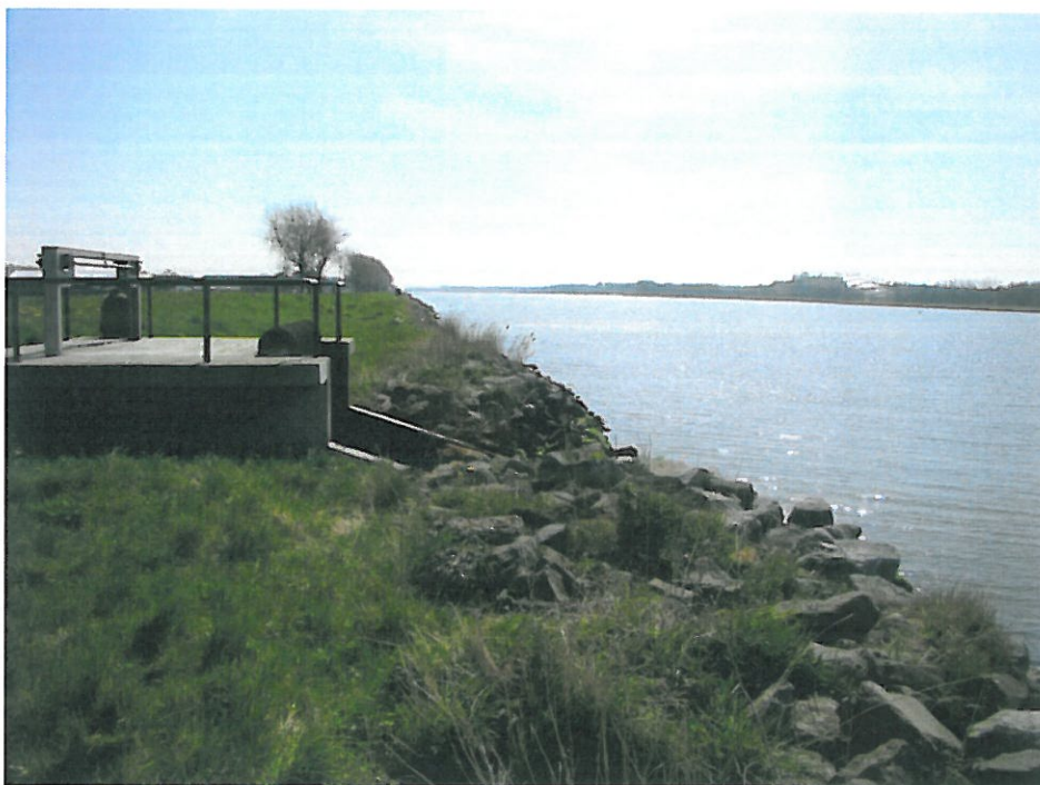
Figuur 5.2 Noordzeekanaal ter plaatse van gemaal
