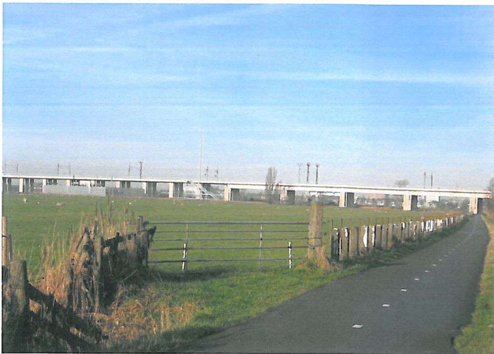
Figuur 6.1 Huidige situatie station Bleiswijk locatie 4C, met de HSL op de achtergrond
