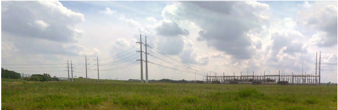
Fig. 4.9d: Beeld van het plangebied in juni 2012. Links de 380kV Krimpenlijn, rechts de R380kV Zuidring in aanbouw. Voor locatie en kijkrichting zie afb 4.9b
