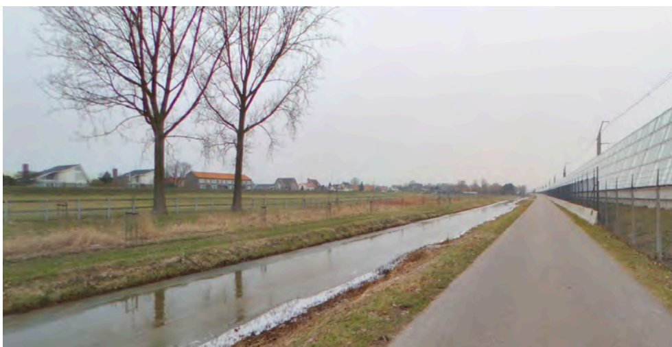
Fig. 4.6.c: Huidige situatie, zone tussen Nieuwe Wetering (links) en de HSL (rechts)
