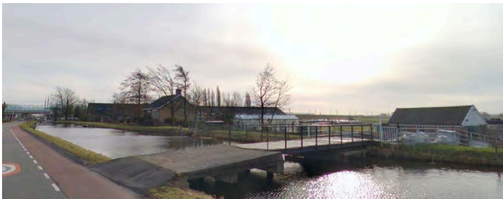
Fig. 4.7d: Huidige situatie, beeld vanuit de Zuidweg in Rijpwetering in zuidelijke richting. Op de achtergrond de HSL en de locatie voor het opstijppunt.
