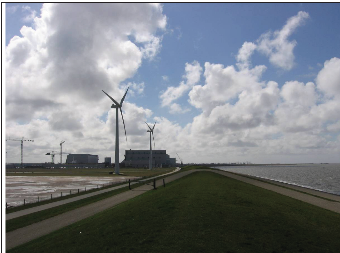
Bedrijventerrein Harlingen; masthoogte 50 meter, tiphoogte 78 meter
