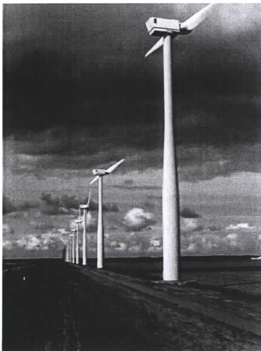
Foto 7: Huidige lijnopstelling langs de Eemmeerdijk
