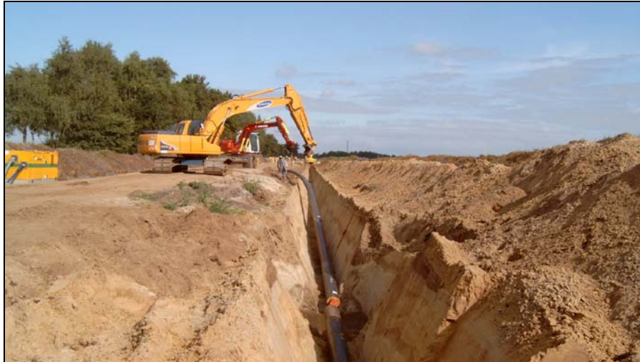
Figuur 37. Aanleg van transportleiding met open ontgraving (Bron: MER, 2008)
