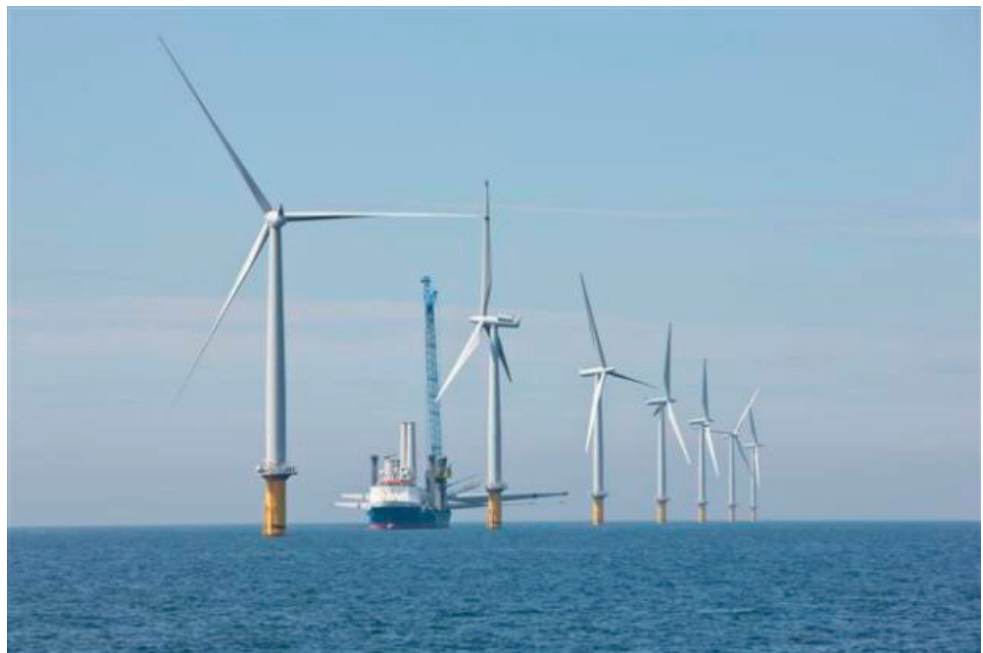
Figuur 5 Voorbeeld 3-5 MW klasse turbine, Siemens 3,6 MW met een rotordiameter van 107 meter
