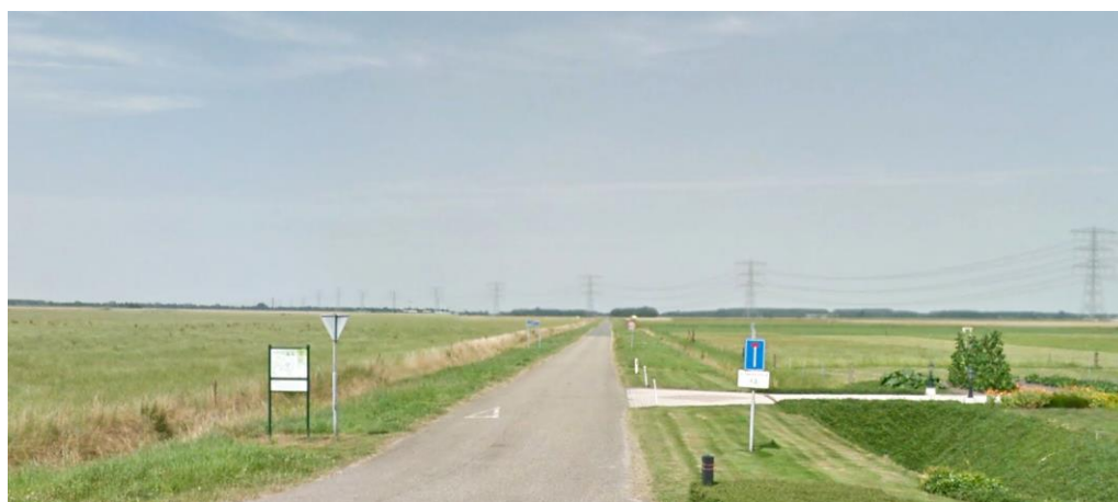
Figuur 3.4 Hoogspanningslijn dwarslopend door het noordelijk deelgebied
