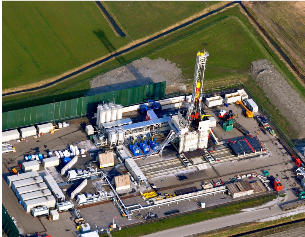
Figuur 2 Boorinstallatie inclusief boortoren en geluidswanden. Deze installatie staat meestal enkele maanden op locatie.
