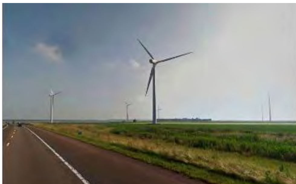
Figuur 5.7: Zicht vanaf de A27 op het open middengebied (turbines met ashoogte 67 m, rotordiameter 8
