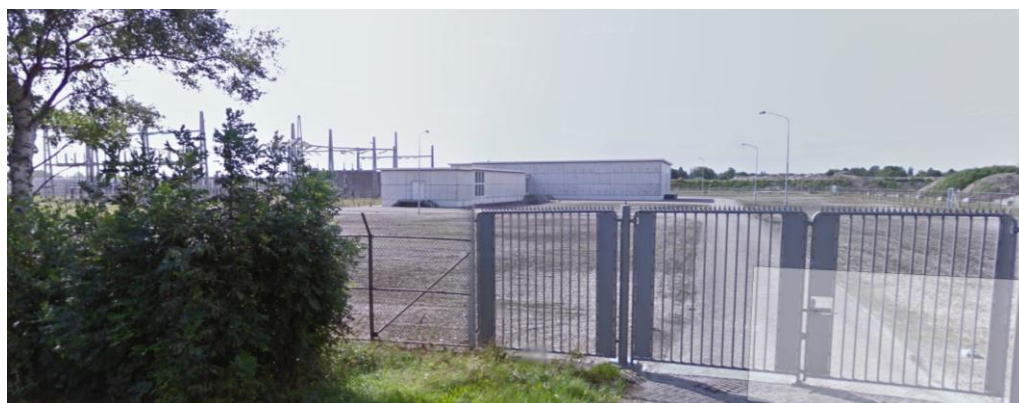
Figuur 2.1 Huidige situatie op het terrein van trafostation Veendam
