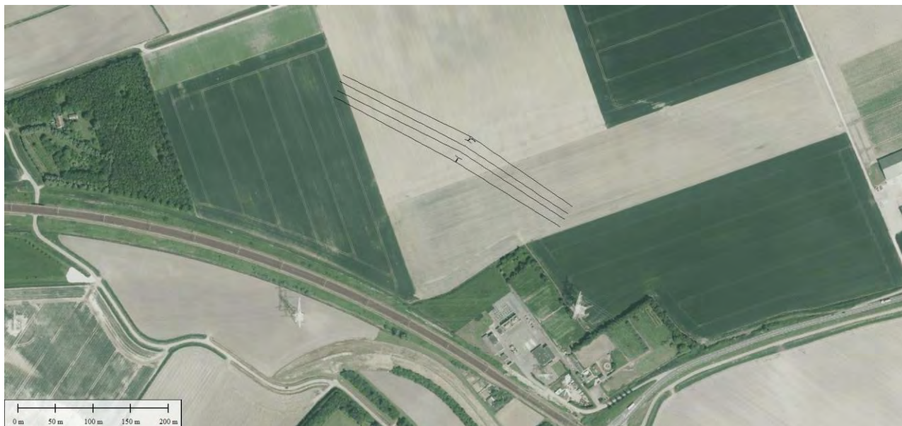
Figuur 1: Overzicht 150 kV opstijgpunt 1066
