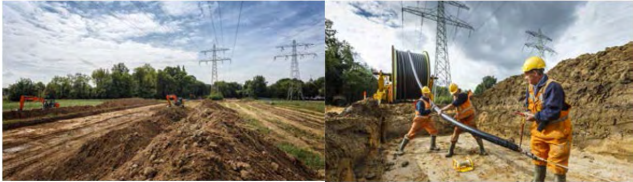
Foto 19: Open ontgraving, sleuven graven en kabels trekken.
