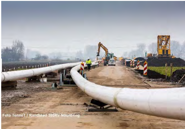
Figuur 6 Boring 2 circuits 380 kV
