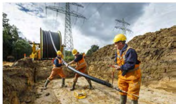
Figuur 7 Uitleglocatie boring van ca. 800 meter, de langste boring in de Noordring.
