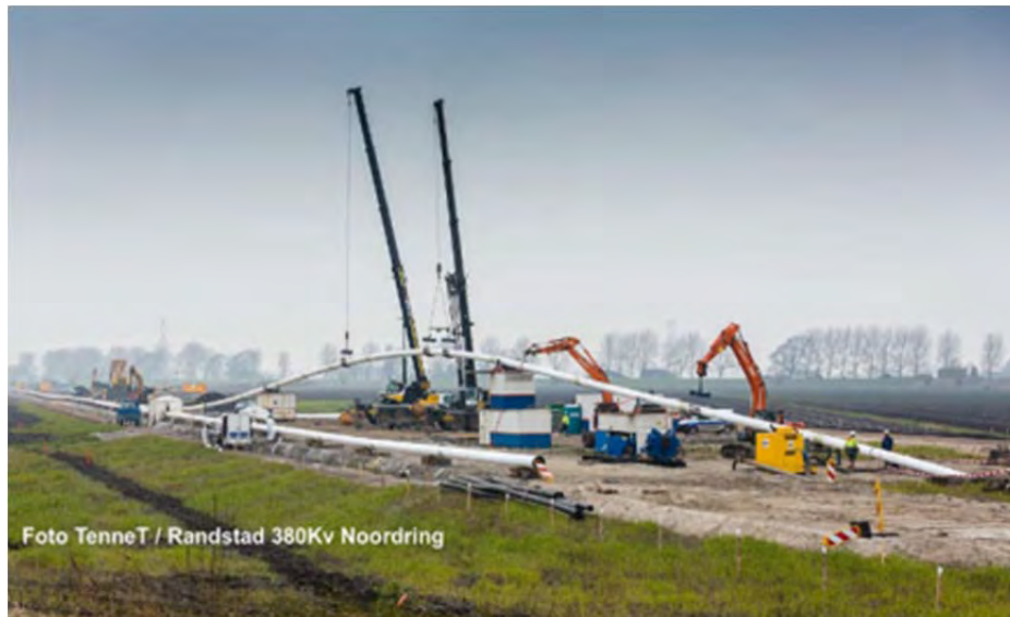
Figuur 16: Boring Randstad 380 kV
