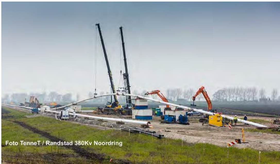
Figuur 5: Boring 2 circuits 380 kV
