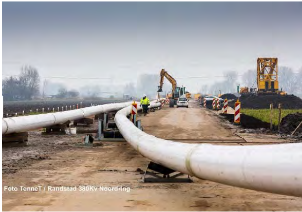
Figuur 6 Boring 2 circuits 380 kV
