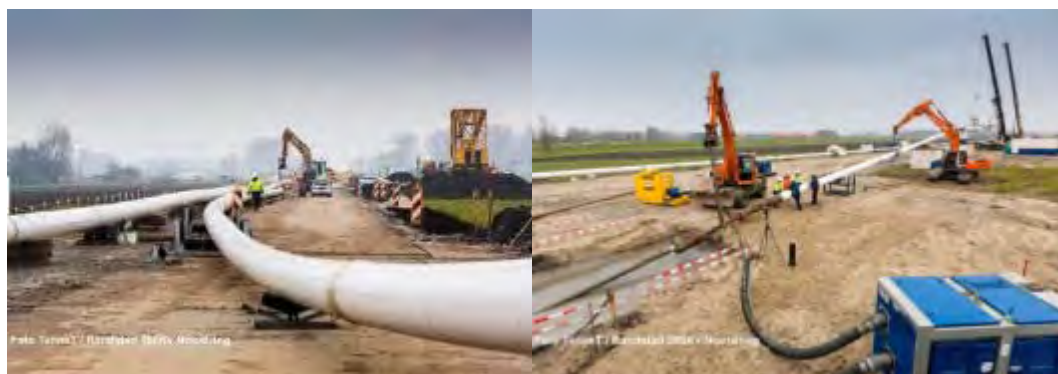
Figuur 17: Boring Randstad 380 kV
